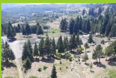
Local do edifício de equipamentos elétricos
