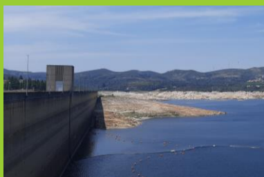
Barragem do Alto Rabagão
